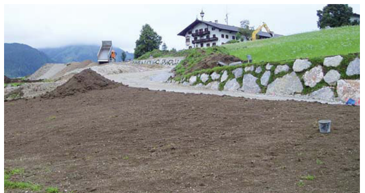
Neuerrichtung Hoferschließung Ampelsbacherhof/Bistum Innsbruck
