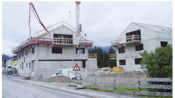
Baustelle Neue Heimat: Die Neue Heimat Tirol errichtet mit der Gemeinde Achenkirch 17 geförderte Wohneinheiten im Urschnerfeld
