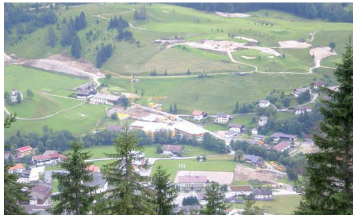
Baustellen Sommer 2009: Baustelle Neubau Mitarbeiterhaus Posthotel Achenkirch/Familie Reiter; Neubau Haus der Gesundheit/Frau Melanie Reiter; Umbau Golfplatz Achenkirch/Alpengolf Achenkirch GesmbH
