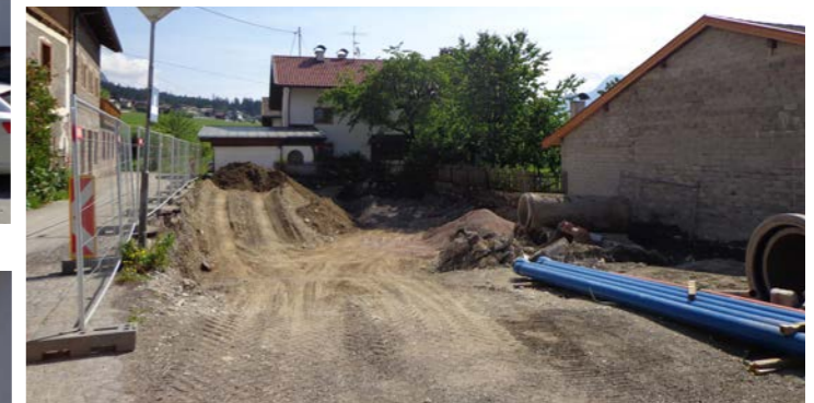
Errichtung Parkplätze hinter Raiffeisenkasse
