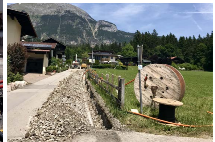
Glasfasernetz - Kabelverlegungsarbeiten in der Rofansiedlung
