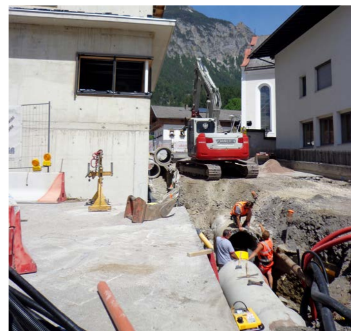
Straßentieferlegung im Zuge der Ortszentrumneugestaltung
