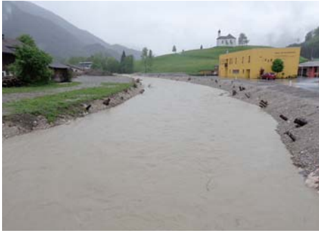
Seeache im Bereich Altenwohnheim
