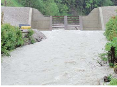
Geschieberückhaltebecken beim Ampelsbach
