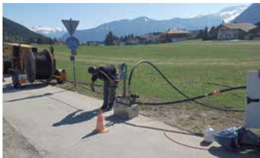
Einblasen des Lichtwellenleiterkabels von Maurach nach Pertisau
