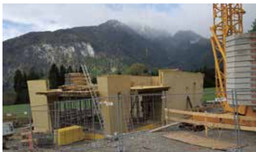
Baubeginn Aufbahrungskapelle in Eben
