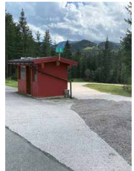
Hinter der Bushaltestelle Unterberg wurde die Loipe verbreitert.
