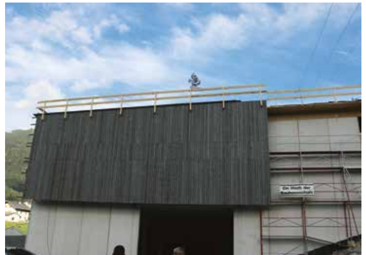
Firstfeier bei der neuen Lagerhalle beim Bauhof
