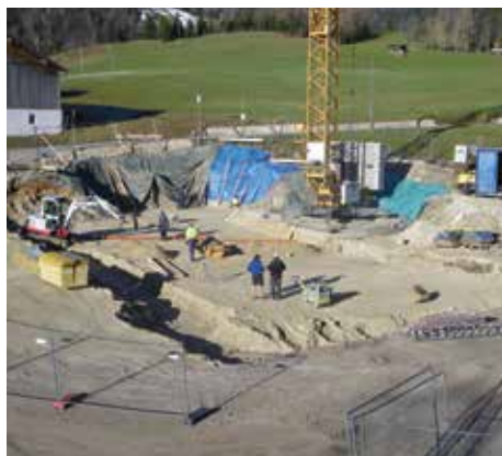
Der Baustart ist geglückt.
