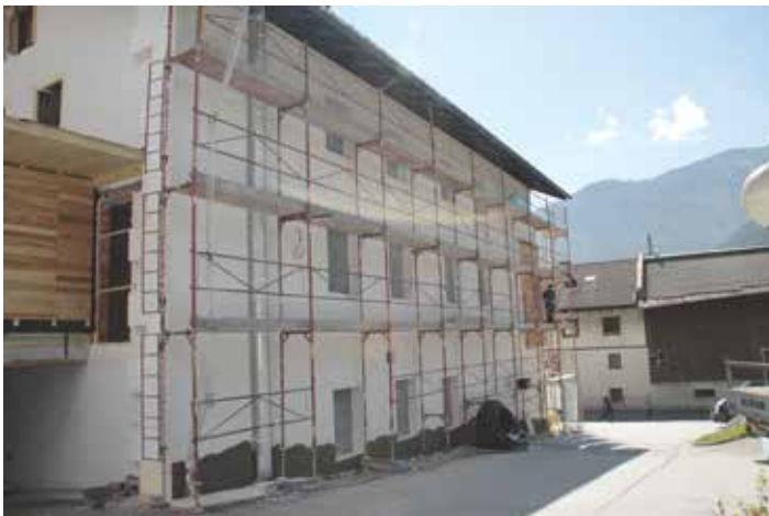
Die Arbeiten am Gemeindehaus schreiten voran.
