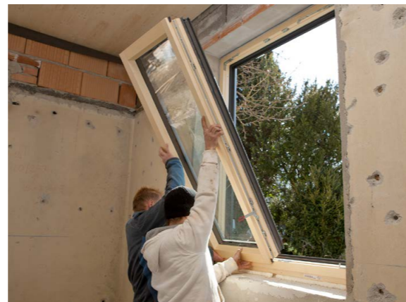
Der Fenstertausch wird idealerweise gemeinsam mit der Fassadendämmung durchgeführt – dadurch können die Anschlüsse optimal und wärmebrückenfrei ausgeführt werden. © Energieagentur Tirol
