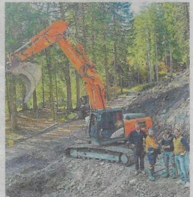
Im Zeitplan liegen die Quelle-Sanierungsarbeiten. Foto: Gemeinde
