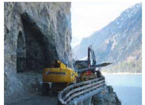
Felssicherungsarbeiten oberhalb des Tunnels, daher ist in diesem Bereich die Straße gesperrt, Radfahrer dürfen durch den Tunnel fahren.
