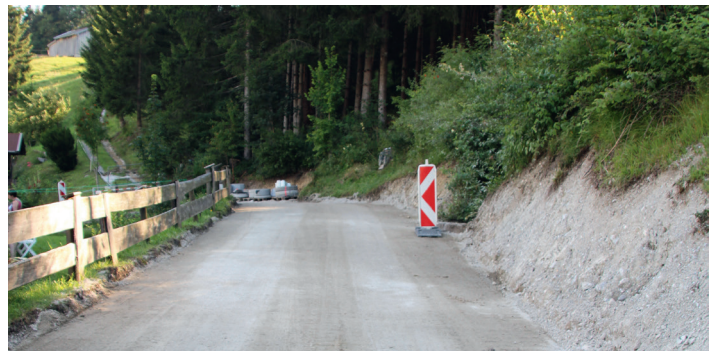
Sanierung der Zufahrt zum „Formerbichl“
