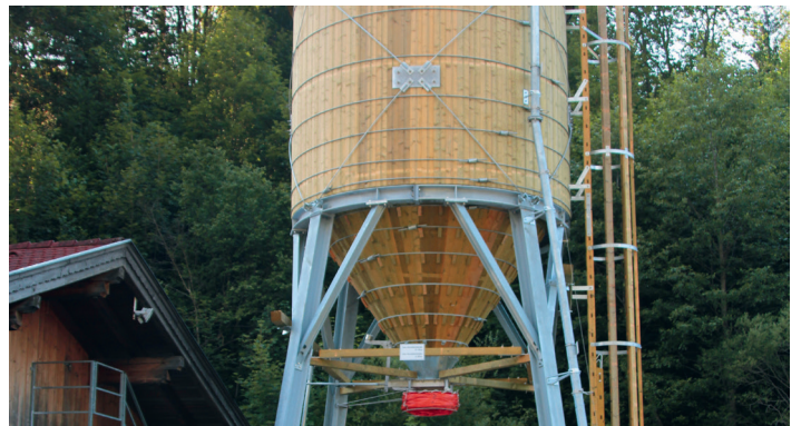
Salzsilo beim Gemeindebauhof in Achenkirch
