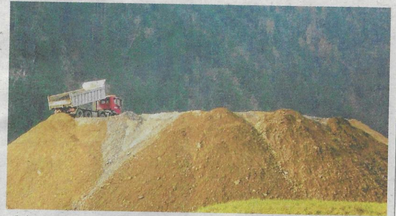
Ob im Weiler Astenberg eine Deponie errichtet wird, hängt von der Behörde ab. Der Ausgang des Verfahrens ist ungewiss. Foto: Archiv
