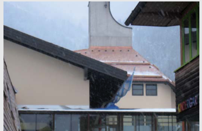
Auch das Kirchendach wurde mit Schindeln eingedeckt.
