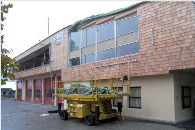
Mit Lärchenschindeln wird im Bereich Feuerwehr/Bergrettung die Außenfassade verkleidet.
