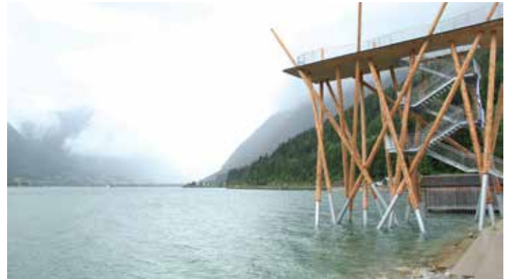
Mit der Fertigstellung des Hochsteges wurden die Arbeiten der Seeuferpromenade in Pertisau abgeschlossen.
