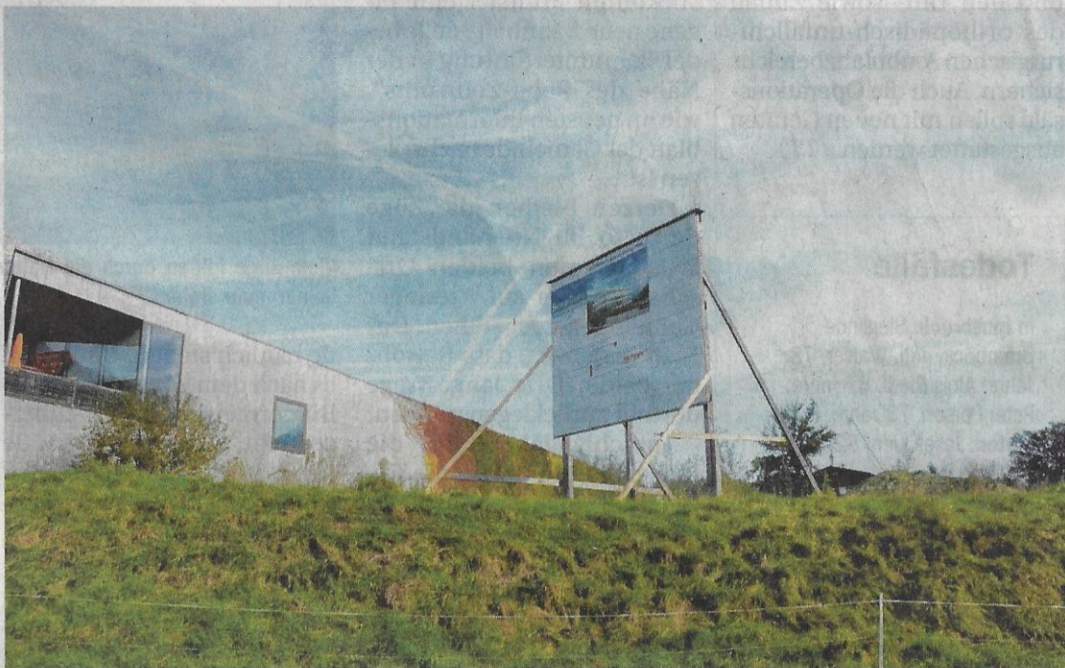
Neben der Achensee-Bundesstraße bei der Autobahnausfahrt Wiesing will die SeneCura die Kinder-Reha bauen. Der Lärmpegel liegt am Tag bei 58 Dezibel, im Wohngebiet gelten 50 Dezibel als Planrichtwert. Fotos: Dähling
