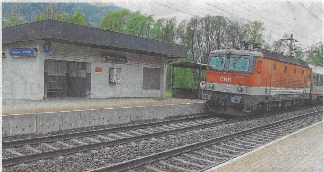
Derzeit existiert die Doppelhaltestelle Münster-Wiesing. Sie liegt zwischen den beiden Ortschaften.
