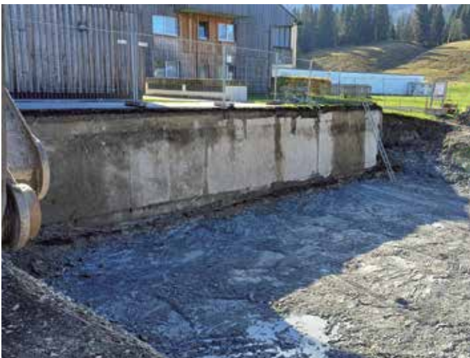
Neuer Wohnraum in Achenkirch: 9 weitere Mietwohnungen entstehen.
