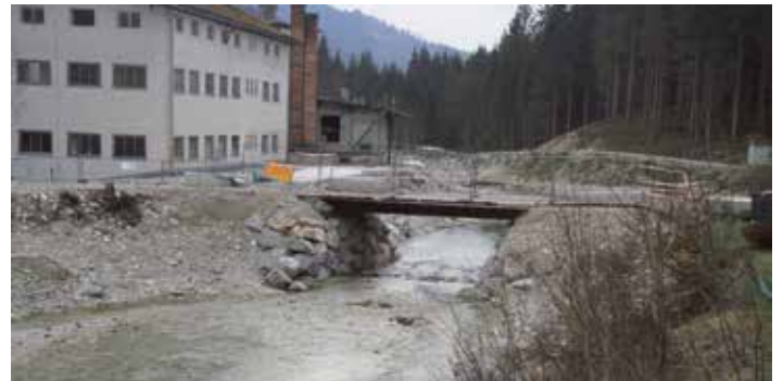
Behelfsbrücke für Fußgänger
