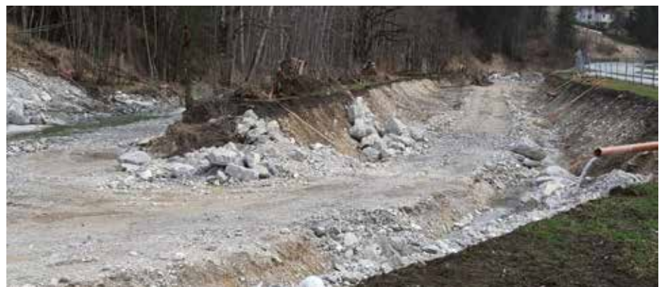
Der „Entlastungsarm“ auf Höhe Schafstätt/Pumpwerk 1 ist bereits gut zu erkennen.
