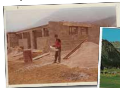
Maurerpolier Josef Marksteiner beim Rohbau des Inntal-Stadls.
