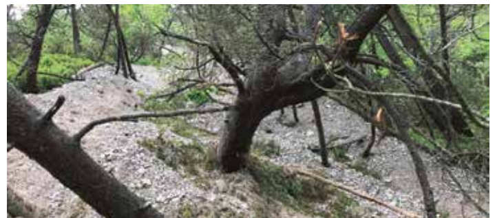
Gewitterschäden auf dem Gaisalmweg
