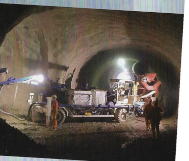
Abb. 8: Zugangsstollen mit Wendekaverne
