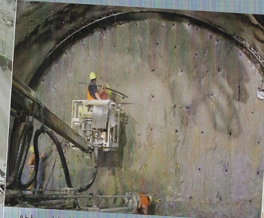
Abb. 4: Vorbereitungsarbeiten zum Sprengen - Besetzen der Ortsbrust für Abschlag
