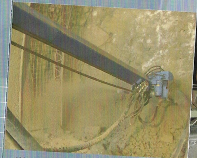
Abb. 6: Einbau Spritzbetonschale
