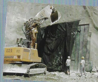
Abb. 3: Schutzvorkehrungen am Portal bei der Sprengung
