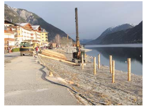
Holzpfähle für die Montage des Holzsteges
