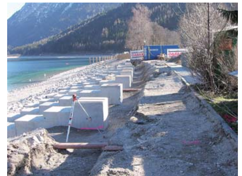
Fundamente für die Sitzstufen
