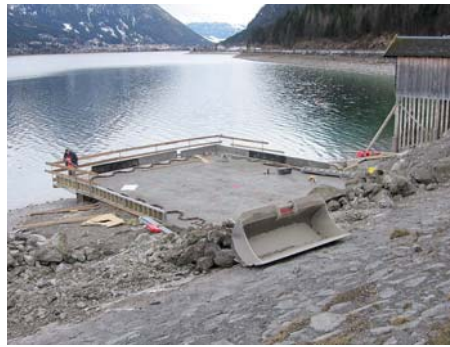
Plattform für den Aussichtsturm
