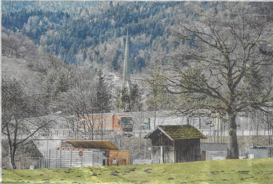
Die Lärmschutzwand wurde um 1,1 Millionen Euro erhöht und verlängert.
