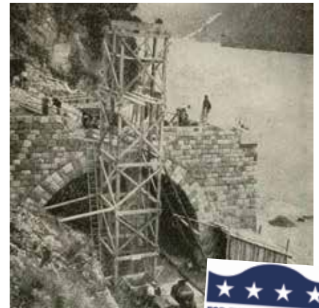
Bauarbeiten am Nordportal des „Achenseetunnels“ und Logo des „European Recovery Program“, welches auch an der Fassade des Nordportals angebracht ist.
