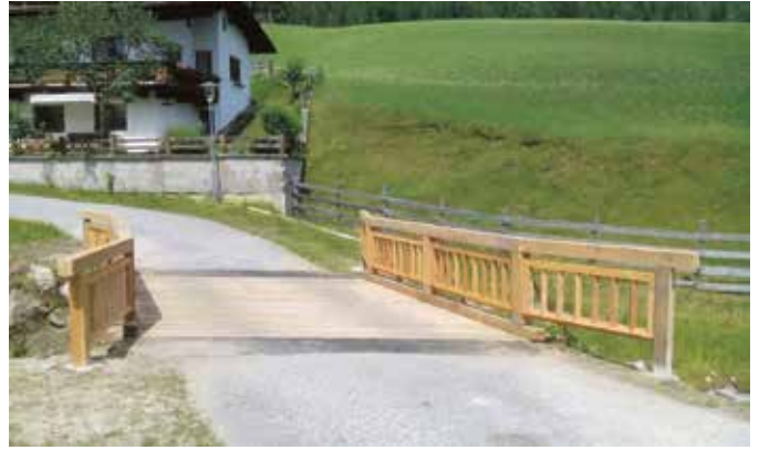
Die Brücke zu den Wohnhäusern „Pulverer“ wurde von den Gemeindearbeitern Georg und Thomas in Eigenregie komplett erneuert und kann sich sehen lassen!
