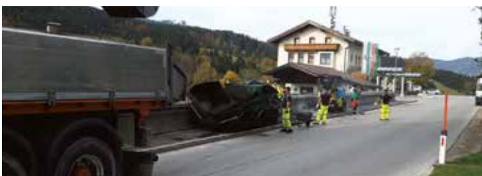
Gehsteigsanierung in Achenkirch
