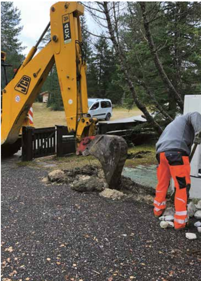
Arbeiten an den Breitband-Hausanschlüssen
