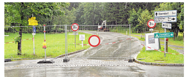
Die Straße über den Rerobichl zwischen Going und Oberndorf ist nach einem Hangrutsch nach wie vor gesperrt. Foto: Zoom-Tirol
