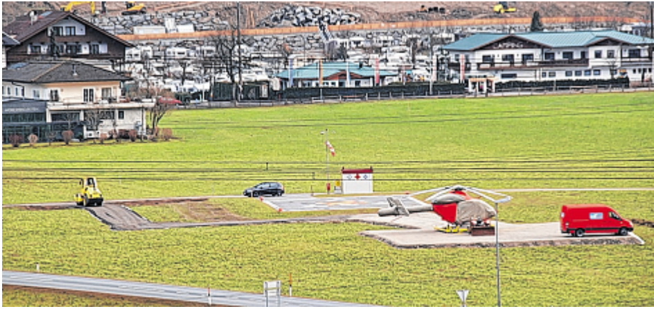
Die Zufahrt zum Knaus-Areal wurde Richtung Norden verlegt – weg vom Landeplatz.
