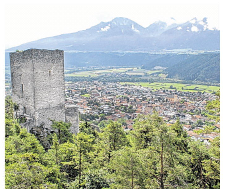
In Zirl ist der Baugrund knapp geworden. 600 Euro pro Quadratmeter werden fällig. Jetzt will die Gemeinde haushalten.
