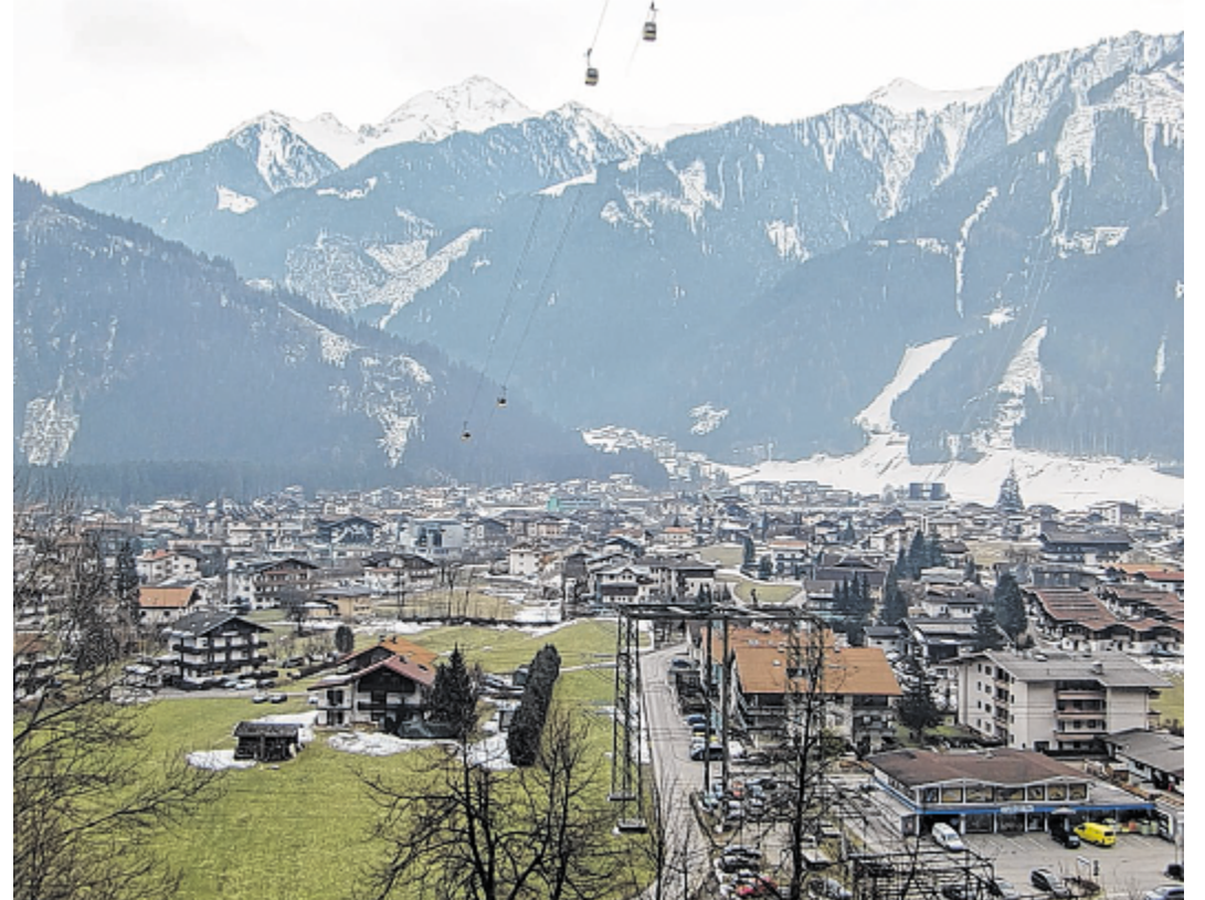
In Mayrhofen wird viel gebaut – mitunter offenbar auch nicht bescheidgemäß. Dass das durch eine Gemeinderätin öffentlich wurde, missfällt dem Bauherrn eines Schwarzbaus. Foto: Dähling
