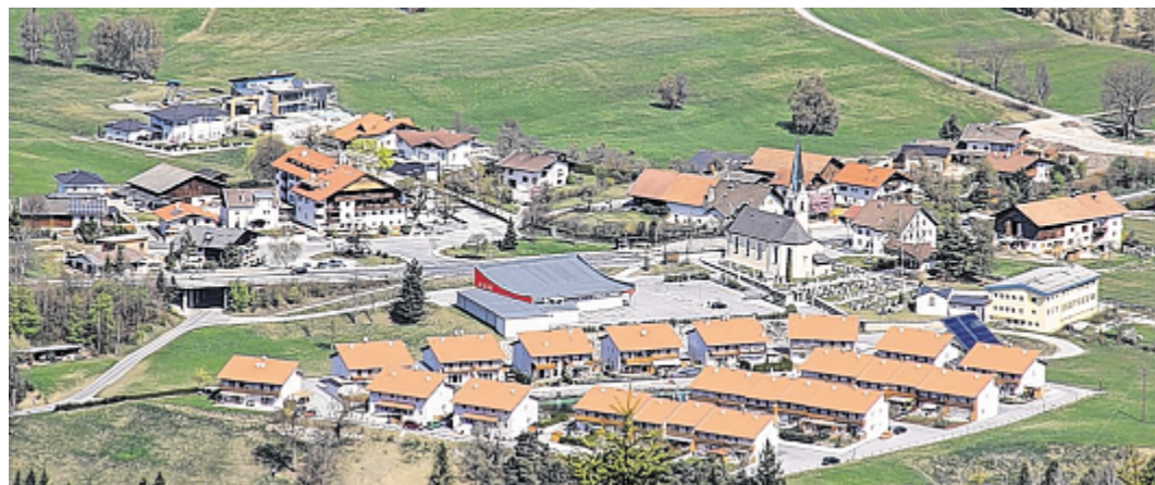
Die Bundesstraße durchschneidet das alte Dorfkern von Obsteig. Foto: Reichle
