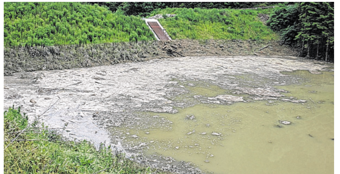
Durch das Retentionsbecken wurden rund 30.000 Kubikmeter Wasser aufgefangen.
