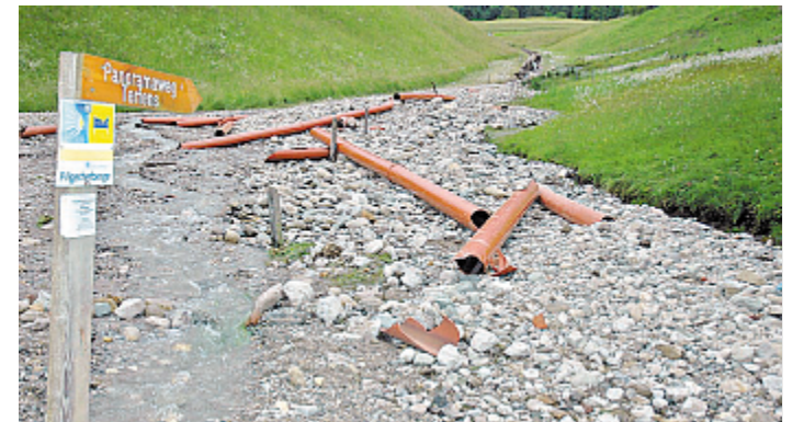
Oberhalb des Beckens wurden Wanderwege weggerissen und der Oberflächenwasserkanal beim Mairbach komplett beschädigt.
