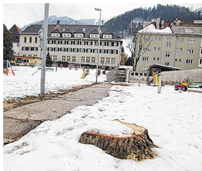
Die Platanenallee im Postpark fiel der Säge zum Opfer. Die flachwurzeln den Bäume beschädigten die betonierten Gehwege.
