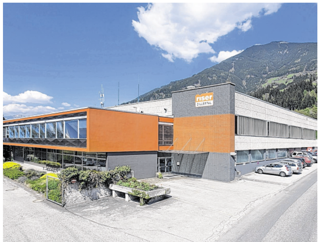
Im Jahr 2003 wurde das neue Firmengebäude der Firma Riser in Stumm fertig gestellt, 2006 erfolgte die Betriebsübernahme durch Haas+Sohn. Jetzt schließt der Betrieb, das Firmenareal soll verkauft werden. Foto: Riser
