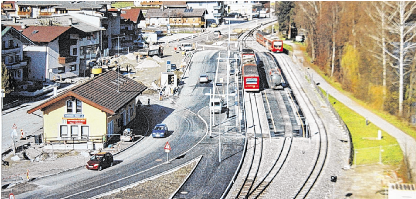
Der Bahnhof Kaltenbach wurde zu einem modernen Knoten für den öffentlichen Nahverkehr ausgebaut.
