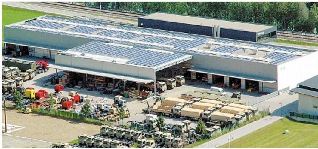
Am Dach des Empl-Firmengebäudes sollen jährlich 430.000 Kilowatt Strom erzeugt werden.
