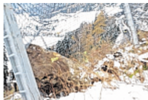
Ein Steinschlagnetz hielt den Felsbrocken auf. Foto: Land-Tirol
