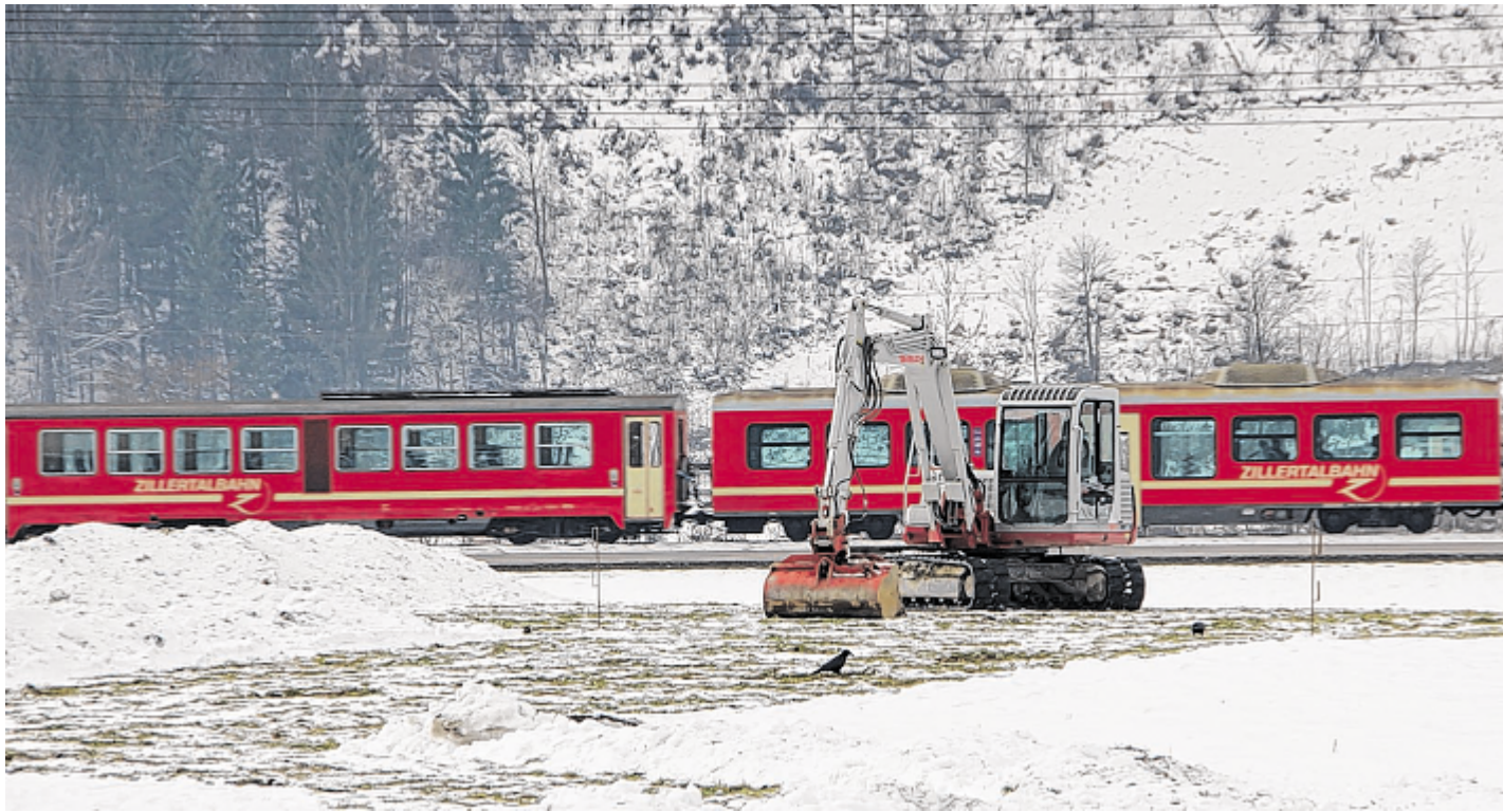
Der Wirbel um den geplanten Hubschrauberhangar – er soll dort errichtet werden, wo der Bagger steht – geht weiter.
