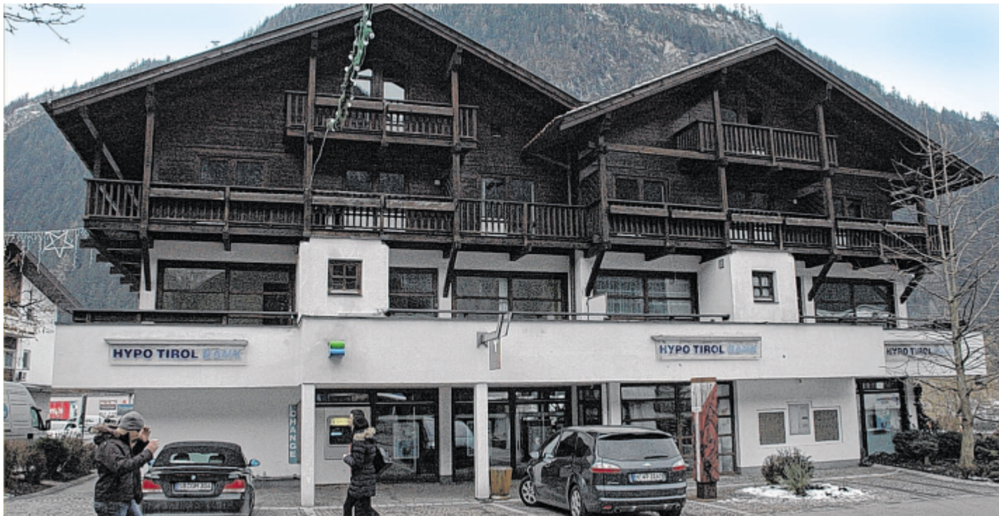
Die Mayrhofner Hypo-Bank-Filiale soll umgebaut werden. Die Gemeinde Mayrhofen hat einen Bebauungsplan erlassen, der die Sache erschwert. Foto: Dähling
