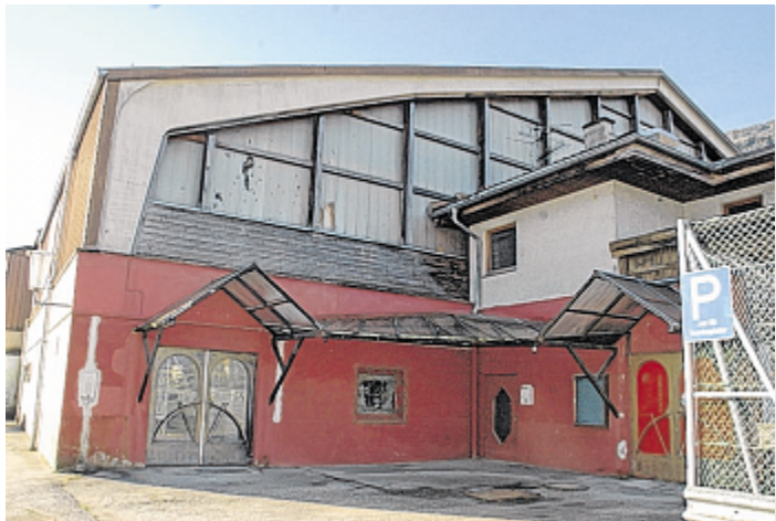
In den nächsten zwei Jahren will man in Kaltenbach Ideen zur Nachnutzung der maroden Tennishalle schmieden und umsetzen. Foto: Dähling
