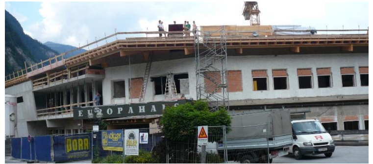
Der Rohbau des Europahauses Mayrhofen steht.
