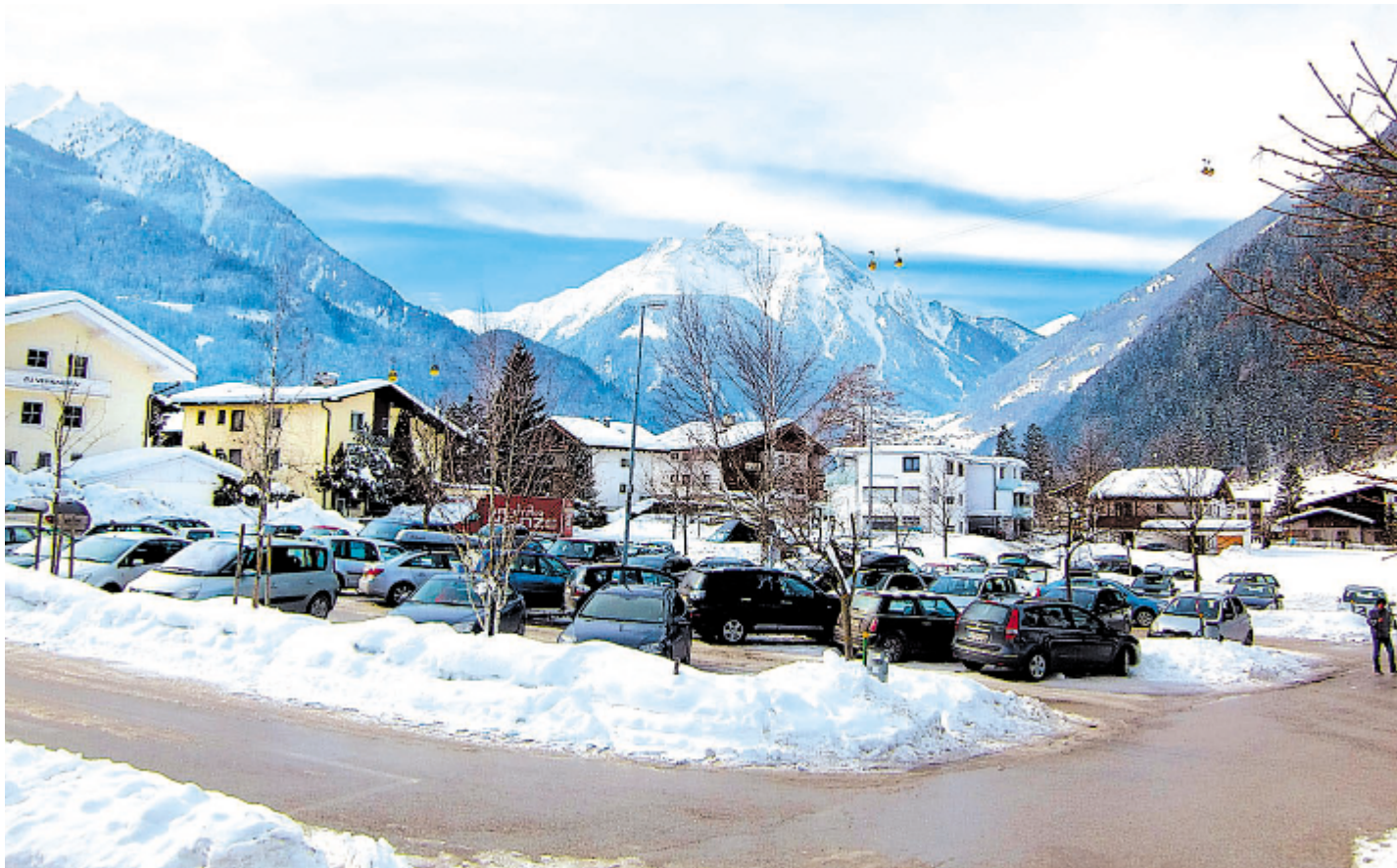
Am Parkplatz Mitte soll das neue Altenheim samt Tiefgarage errichtet werden. Die Gemeinde würde das Areal um zwei Mio. Euro verkaufen. Fotos: Dähling
