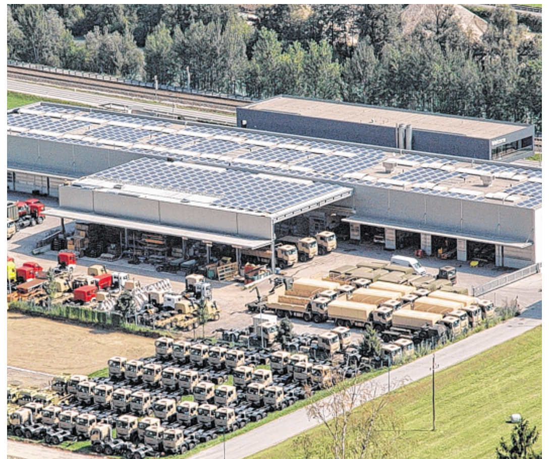
Am Dach der Firma Empl befindet sich eine riesige Photovoltaik-Anlage. Die Zillertal-Gemeinden setzen sich im Rahmen der Energie-Modellregion dafür ein, dass erneuerbare Energien verstärkt zum Einsatz kommen. Foto: Dähling
