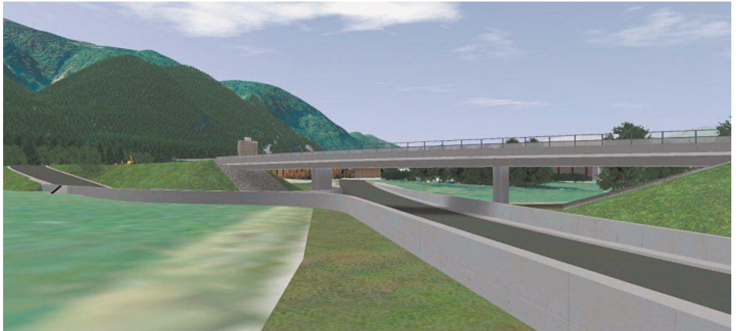
Für das neue Gleis zur Firma Pfeifer sind große Brückenbauten über die Bundesstraße notwendig.
