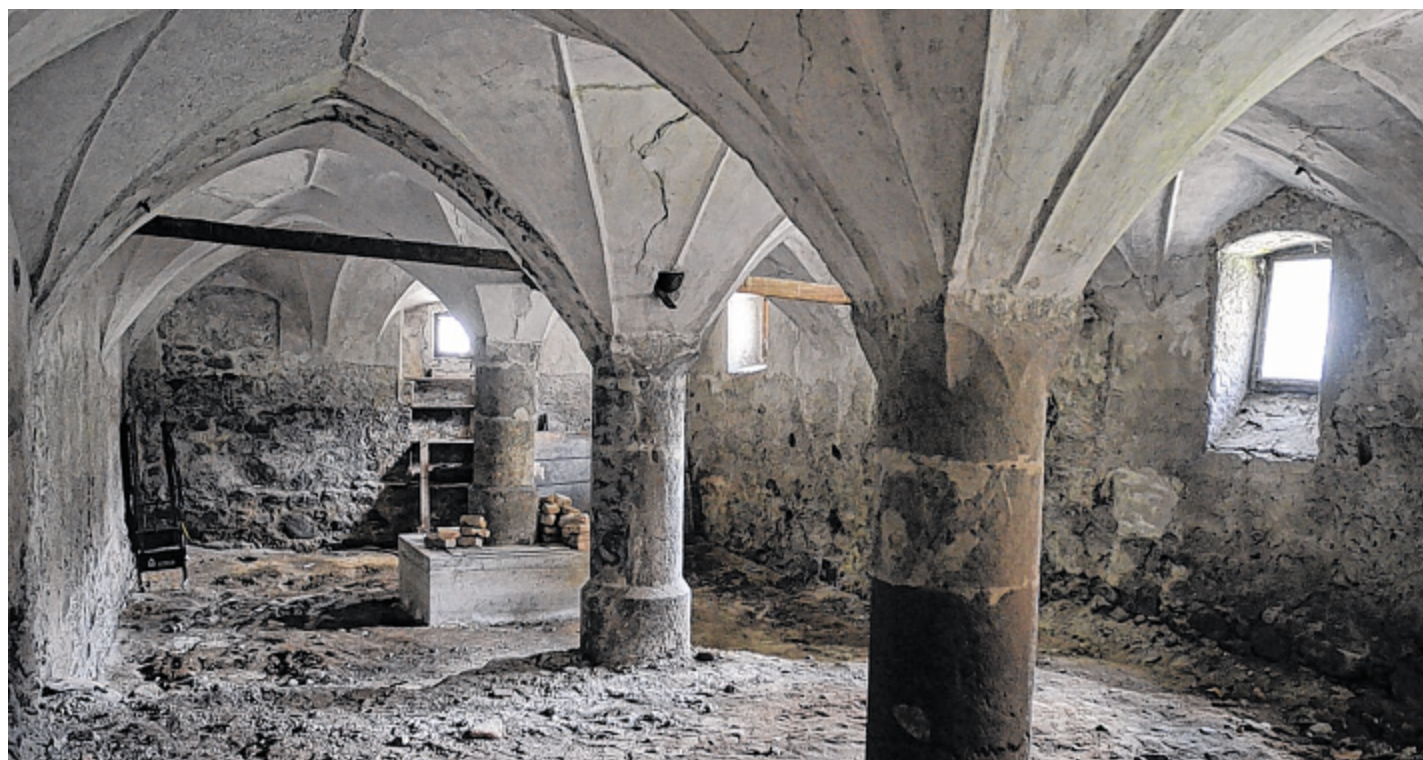
Durch den Mauerabriss ist ein großer Saal im Erdgeschoß des Mathoi-Hauses entstanden. Bis Mai 2014 soll alles in neuem Glanz erstrahlen.
