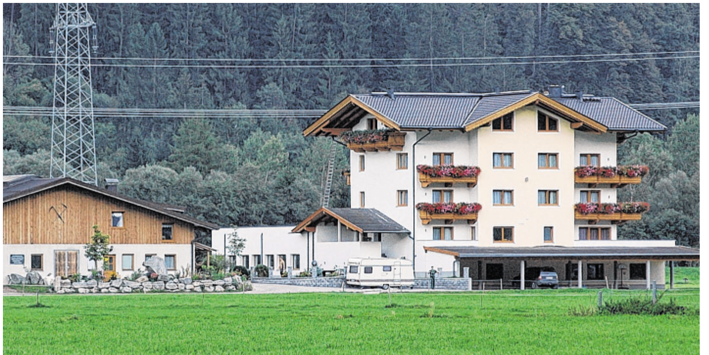
Um die nicht bescheidgemäß errichtete Hofstelle (rechts) in den Uderner Feldern tobte ein sechsjähriger Rechtsstreit.
