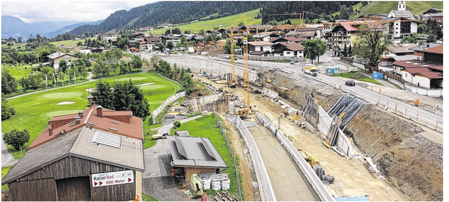
Bis zu sechs Meter tief wird die neue B178 nach unten verlegt.
