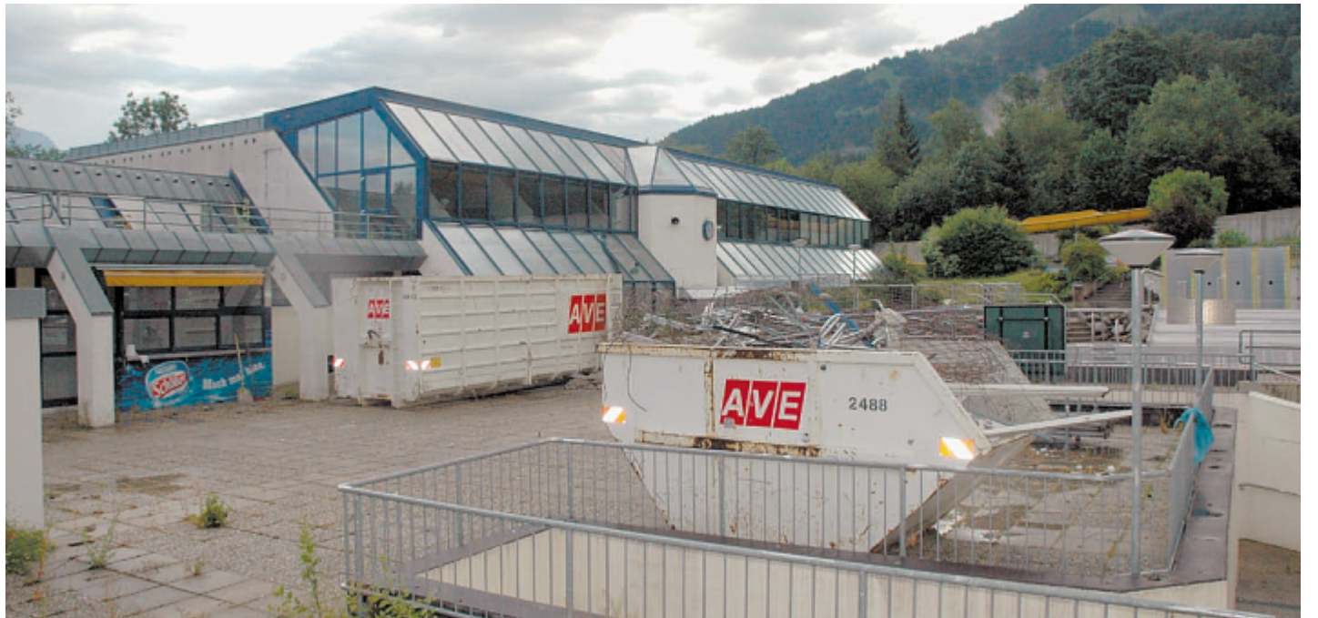
Bis Dezember soll aus der Baustelle im Söller Erlebnisbad eine Wellnessoase werden.
